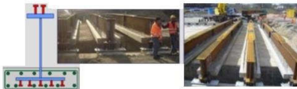
Рис. 5. Сталезалізобетонні прогонові будови із застосуванням preflex-балок
